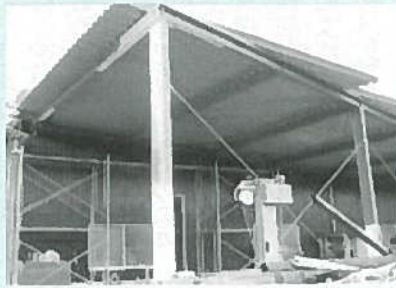
店舗施設の改修(自動車整備業)
